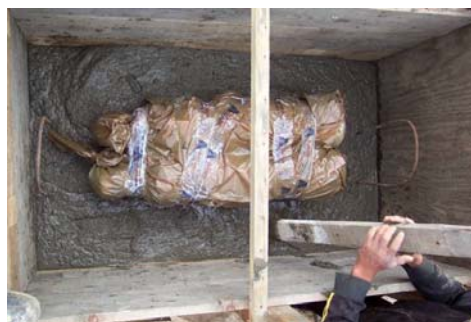
Foto N° 1 Macroencapsulado de residuos peligrosos en un "sarcófago"
