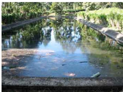
Foto 4 Laguna anaeróbica para el tratamiento de aguas mieles de café (Diseño: Manuel E. López M. - EASA Consultores)
