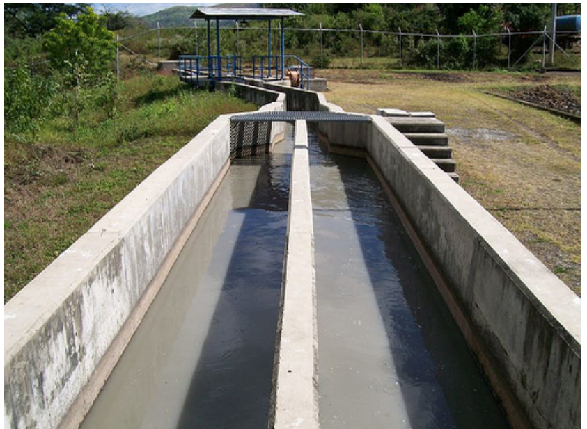
Foto 6 Desarenador en Planta de Tratamiento de Aguas, Matagalpa (Foto: Enrique Padilla)
