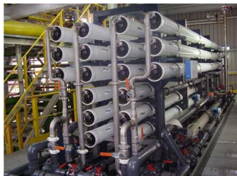
Foto N° 4 Sistema Becox de ósmosis inversa ( www.quimicauniversal.com )
